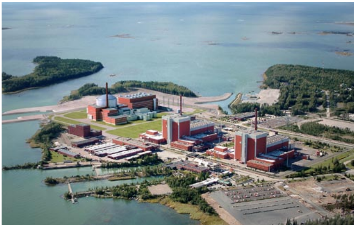
Finlands nya reaktor i Olkiluoto i färdigt skick (fotomontage). Det är anläggningen längst ut på udden som håller på att byggas. Den har en effekt på 1600 MW. De övriga två befintliga verken har en effekt på 840 MW vardera.
