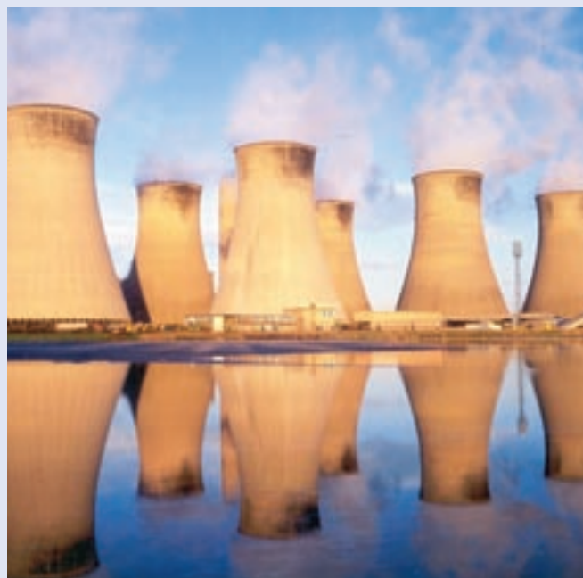
Europa står inför en utbyggnad av sina energianläggningar. På 25 år ska 600 000 MW i ny elproduktion byggas ut, delvis för att ersätta gamla anläggningar. Det är 20 gånger hela det svenska elproduktionssystemet. Foto: LPC, kolkraftverk i England
