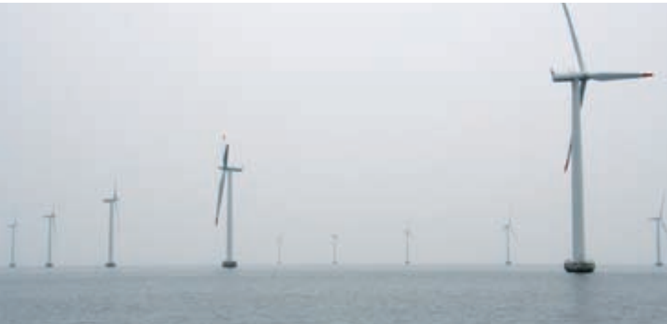
Framtidens vindkraft kanske? Världens största havsbaserade vindkraftpark, Nysted i Danmark, innehåller 72 kraftverk. De producerar 0,6 TWh per år, nästan lika mycket som hela Sveriges vindkraft gav förra året.
