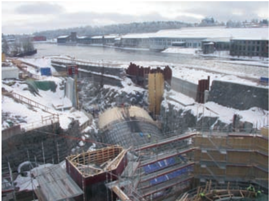
Efter mycket om och men byggs nu Avestaforsen om, främst för att kunna ge mera el och för att öka säkerheten. Hela bygget blir klart år 2008.
