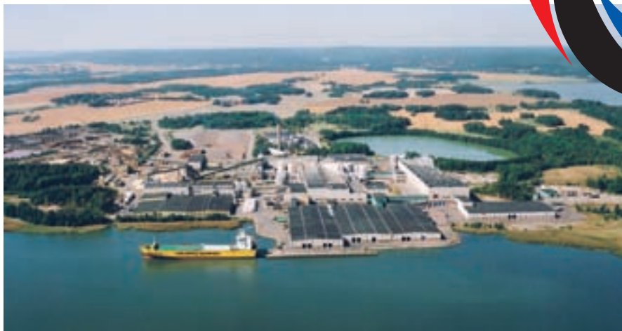
Industrin – här Bravikens pappersbruk – både köper in energi och har sina egna energi-anläggningar. Lönsamheten avgör vilka effektiviseringar som görs.
