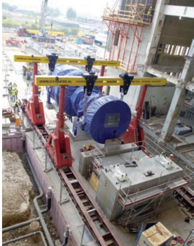
Hjärtat i anläggningen, den nya gasturbinen, lyfts in i Öresundsverket.
