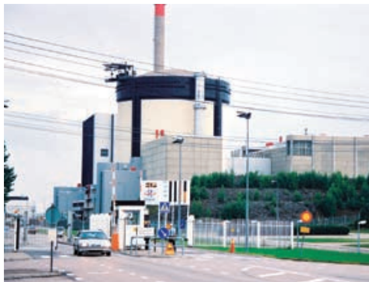
Kärnkraften är den största spillvärmekälla som existerar i Sverige. Foto: Ringhals, Vattenfall.
