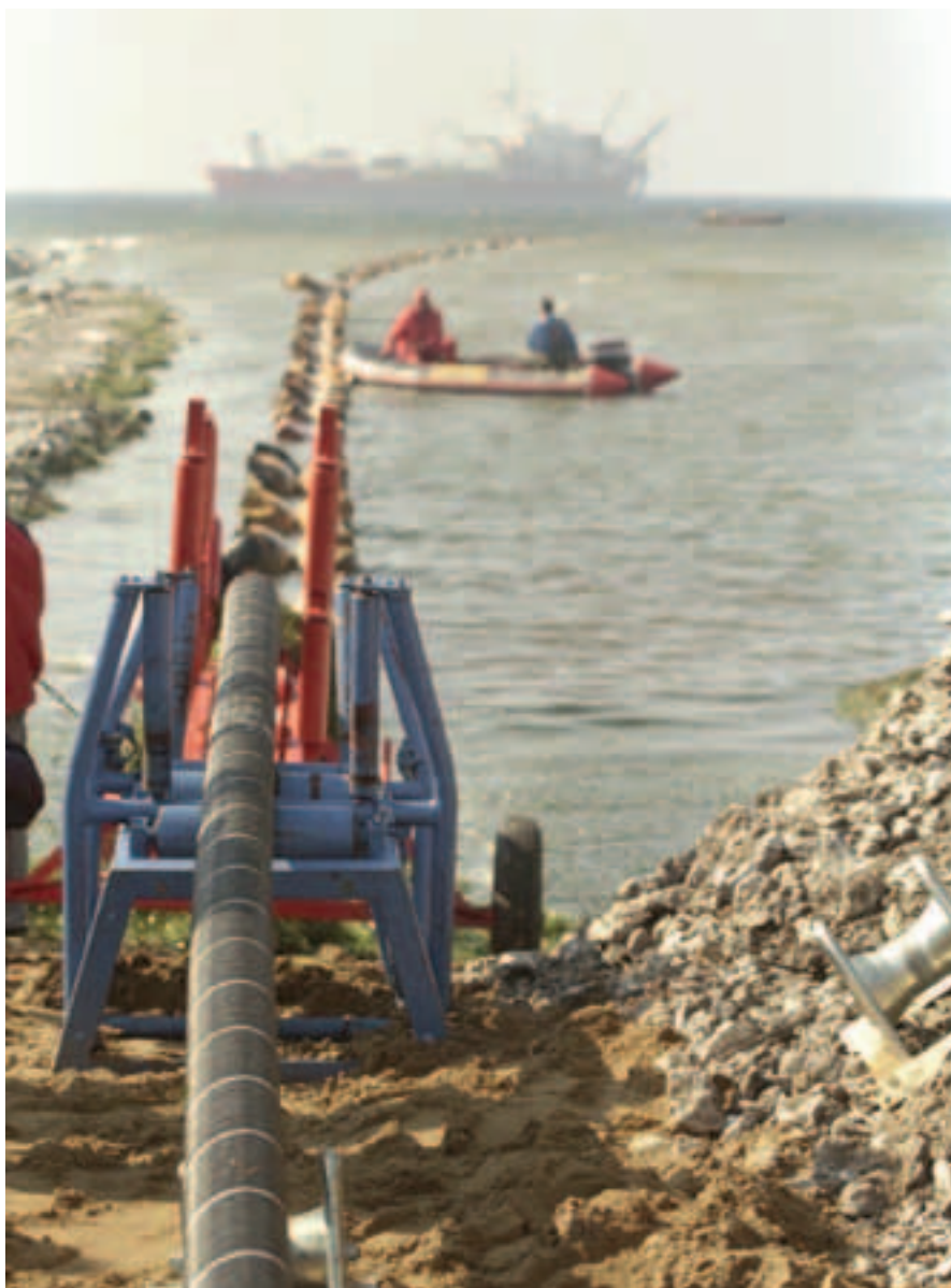
Utläggning av Baltic Cable som togs i drift 1994. Kabeln förbinder Sverige och Tyskland. Foto: Hans Blomberg
