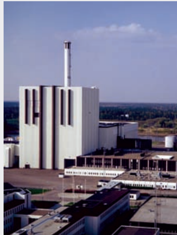
Foto: Forsmark, Vattenfall
